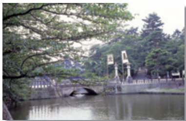
明治時代に造られた舞鶴橋
