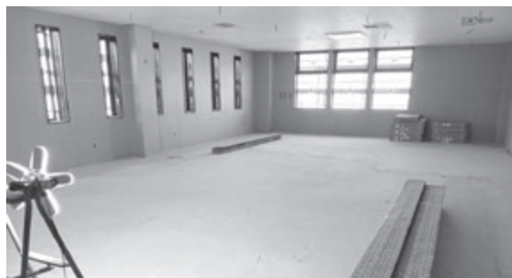
新会館の貸事務所(工事中)
