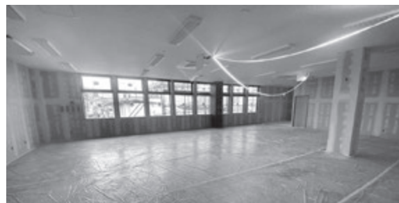
米沢商工会議所の事務所(工事中)
